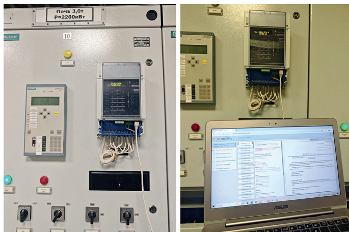
Рис. 2. Внешний вид многофункционального анализатора ПКЭ «BINOM3» и его Web-интерфейса Fig. 2. Appearance of the «BINOM3» multifunctional electricity quality indicators analyzer and its Web interface
