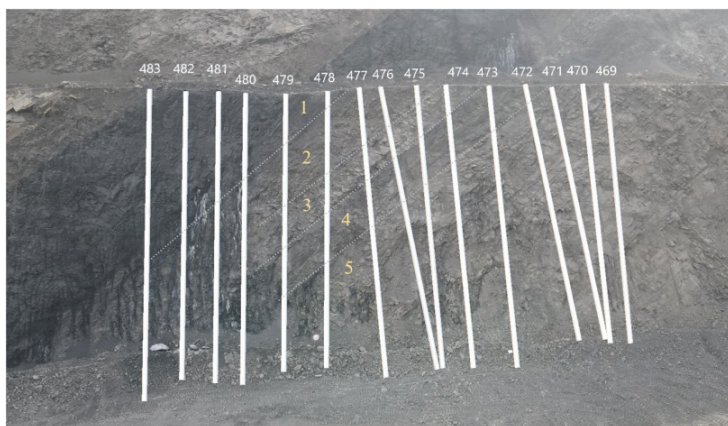
Рис. 1. Фотография откоса и исследуемых скважин контурного ряда (Цифровые обозначения: 1 – уголь; 2 – алевролит; 3 – песчаник; 4 – алевролит; 5 – песчаник) [составлено авторами]
