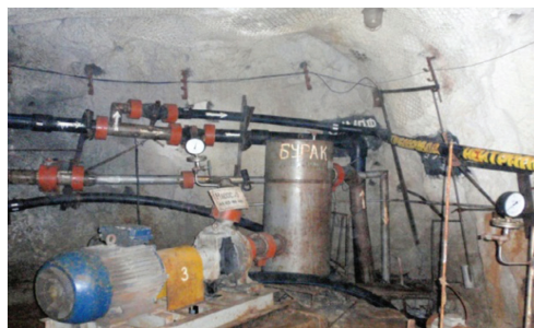
Рис. 5. Сорбционные колонны СНК в выработках Fig. 5. Sorption columns of SNK in the workings
