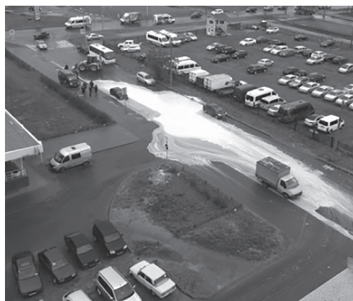
Рис. 1. Разлив бентонитового раствора на Бухарестской улице
