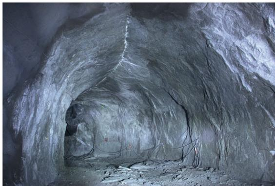
Рис. 1. Пример разрушений приконтурного массива горной выработки в динамической форме на руднике «Олений ручей» (фото А.В. Пантелеева)
