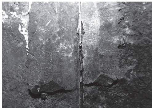
Рис. 4. Запрессованный свинец в стыке фланцев тубингов
