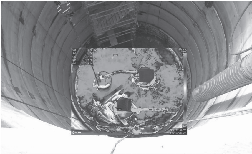
Рис. 1. Температура в забое строящегося ствола; тепловизионная съемка, проведенная в стволе строящегося калийного рудника в Республике Беларусь
