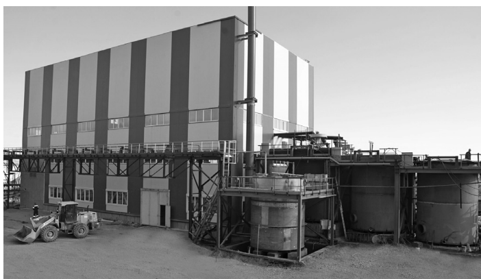
Рис. 1. Отделение нейтрализации серной кислоты на ОАО «Святогор»
