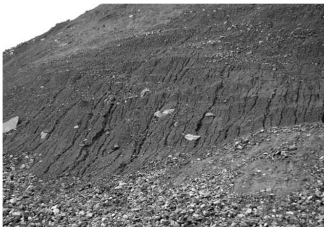
Рис. 3. Промоины мелкодисперсного грунта на откосе после осадков
