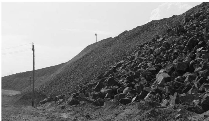
Рис. 1. Выравнивание крупнокусковатой поверхности откоса среднекусковатой скальной вскрышей
