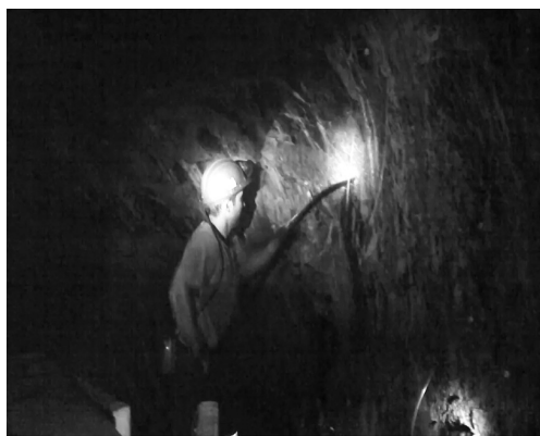
Рис. 3. Зарядка шпуров ЭВВ Украинит-ПП-2 в условиях шахт ЗАО «ЗЖРК» (общий вид)
