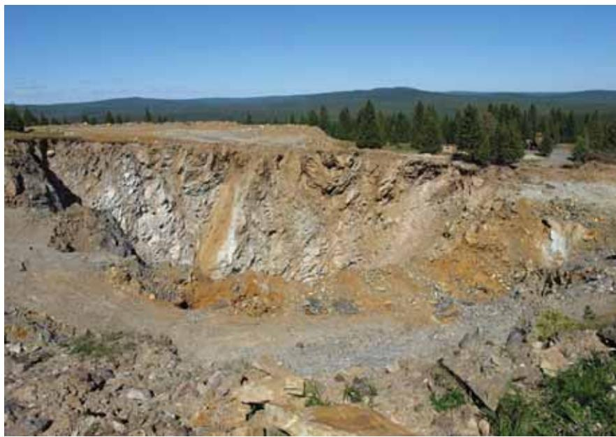
**Рис. 1. Внезапное обрушение земной поверхности и образование провала на Южном фланге**
