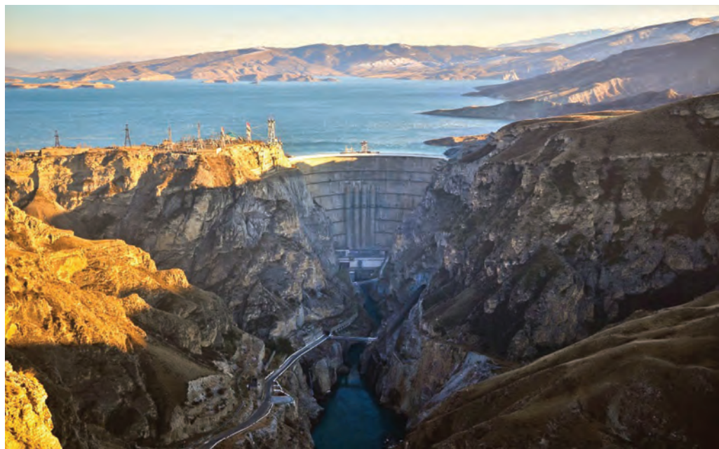
Рис. 9. Вид на Чиркейскую ГЭС
