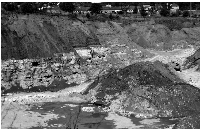
Рис. 1. Проявления процессов подтапливания и оползания в известняковом карьере
