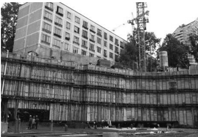
Рис. 2. Крепление стенок котлована анкерами [4]
