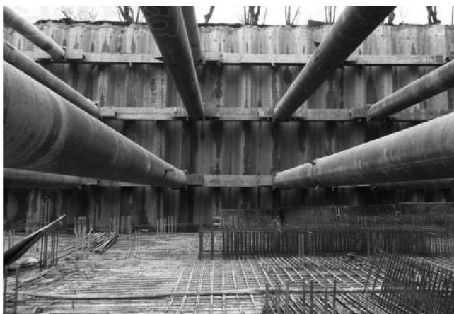
Рис. 1. Крепление стенок котлована распорками [3]
