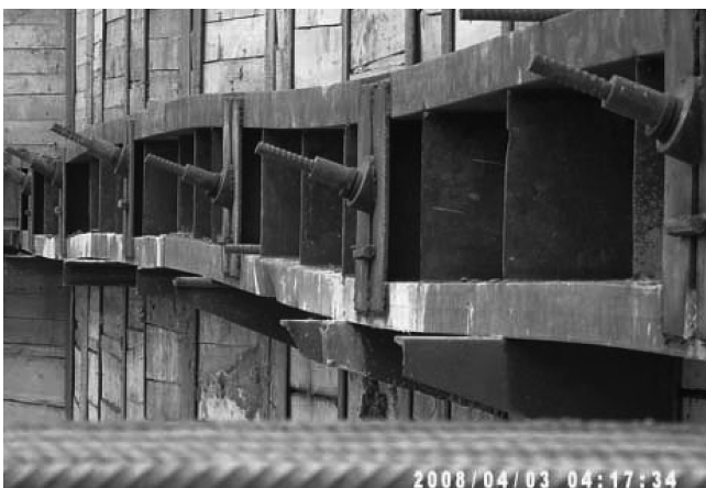
Рис. 3. Распределительный пояс после натяжения анкеров [6]
