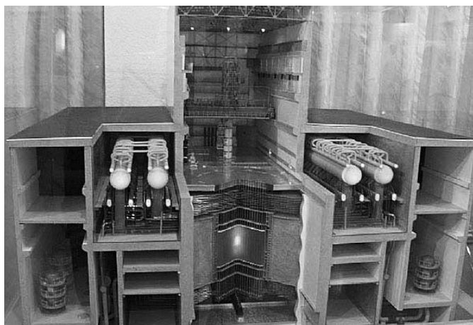
Рис. 1. Конструкция канального энергетического реактора РБМК-1000
