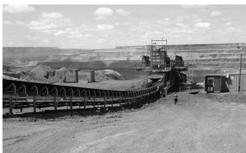
Рис. 4. Конвейерный подъемник на вскрышных работах разреза «Восточный»
