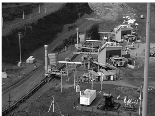
Рис. 3. Пуск в эксплуатацию циклично-поточного вскрышного комплекса (ЦПБК) на разрезе «Восточный»
