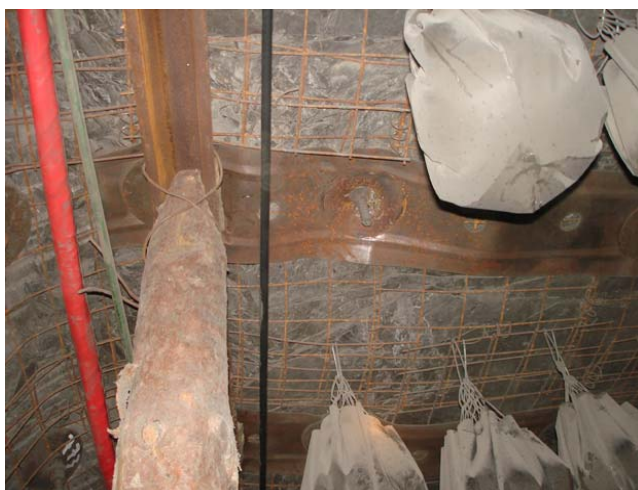
Рис. 3. Деформирования элементов крепления выработки
