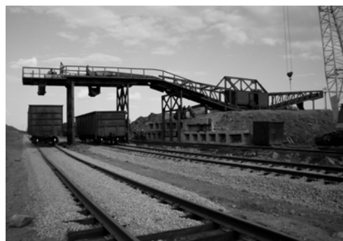
Рис. 3. Конструкция комплекса ДСКА производительностью 1000 т/час в варианте поставки ОАО «Шубарколь Комир» (Республика Казахстан)
