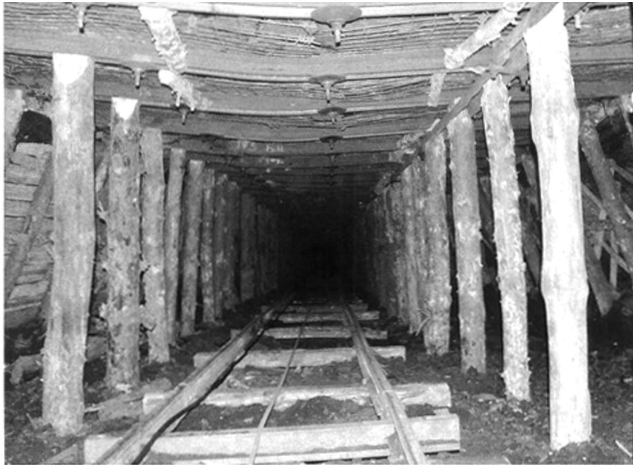
***Рис. 7. Состояние центральной части выработки на момент окончания наблюдений***
