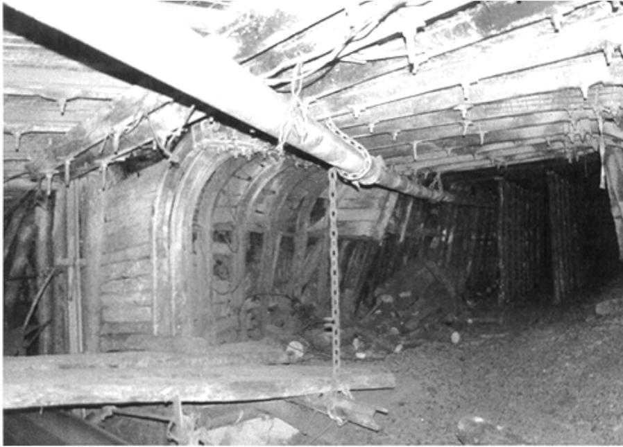
***Рис. 6. Состояние сопряжения монтажного ходка с конвейерной выработкой на момент окончания наблюдений***
