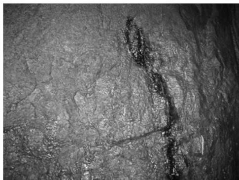
**Рис. 1. Трещинный характер нефтепроявлений в выработках рудника «Удачный»**
