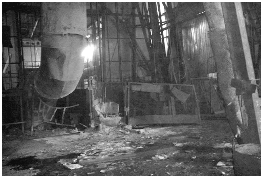
Рис. 3. Разрушения внутри копра
