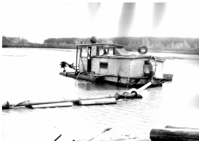
**Рис. 3. Земснаряд для добычи сапропеля и очистки водоемов**
