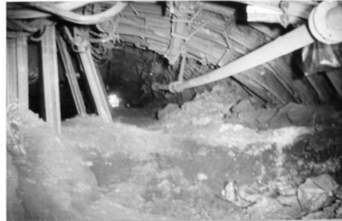
**Рис. 4.** Состояние арочной крепи в момент подрыжки пород почвы на расстоянии 230 м вслед за лавой при применении жестко-продольной крепи усиления
