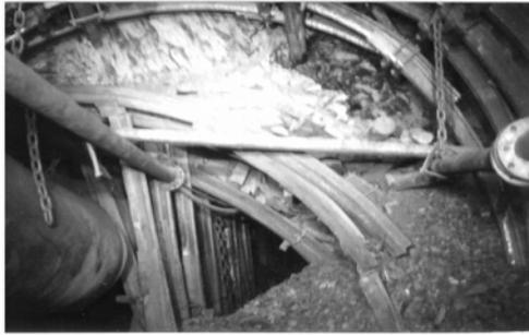
**Рис. 3.** Состояние арочной крепи конвейерного штрека в момент перекрепления на расстоянии 220 м за забоем 2-й западной лавы без применения крепи усиления
