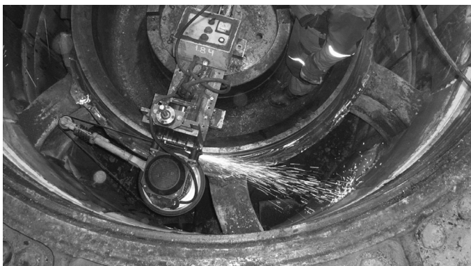
Рис. 2. Восстановление опорных поверхностей КСД
