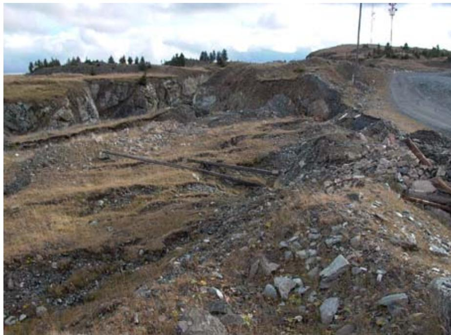
**Рис. 4. Приращение зоны обрушения в направлении шахты**
