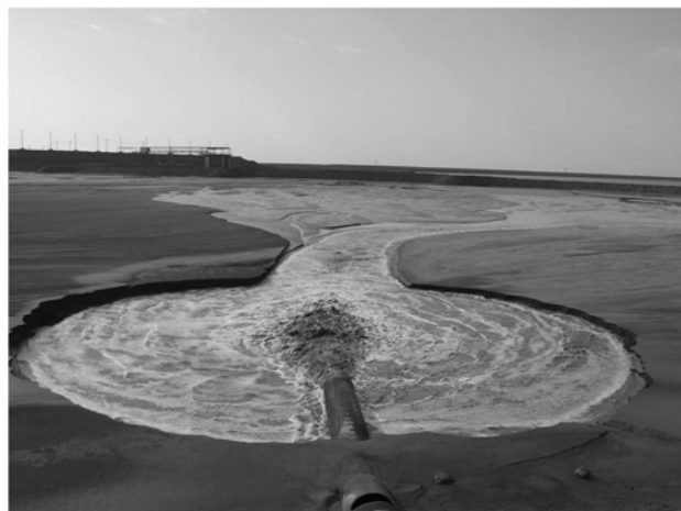
Шламохранилище Северного ГОКа
