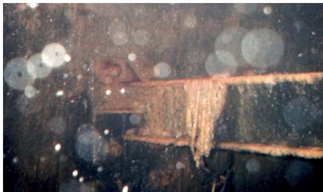
**Рис. 3. Накопление минеральных солей на расстреле в стволе с сильным капежом**
